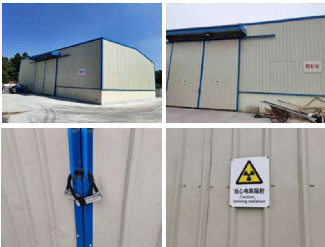
图 4.2-3 独居石暂存库实景照片
