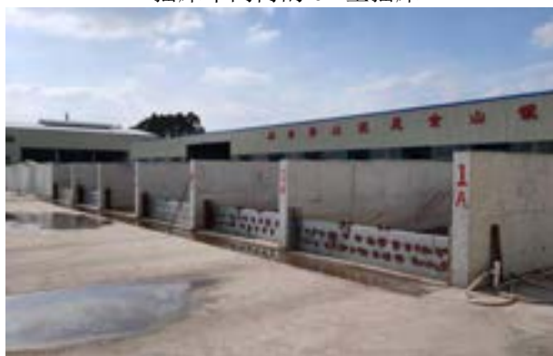
1#半成品堆放区
